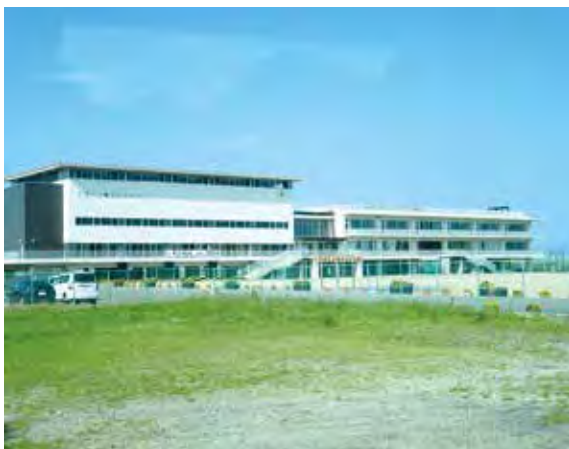
▲2階以上に教室を設置した巨理町立荒浜中学校
